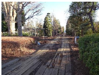
農道に敷かれた枕木
