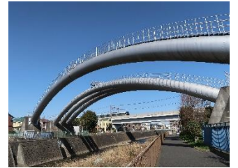
境川に架かる水管橋
