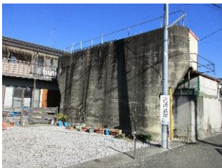
京王御陵線橋脚跡
