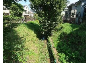
開渠となって現れた玉川上水 (笹塚・渋谷区)
