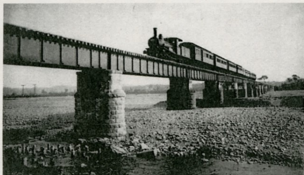
大正時代の中央線多摩川鉄橋（日野煉瓦造りの橋脚） 佐藤元雄家提供写真
