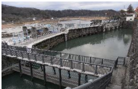
玉川上水の取水堰
